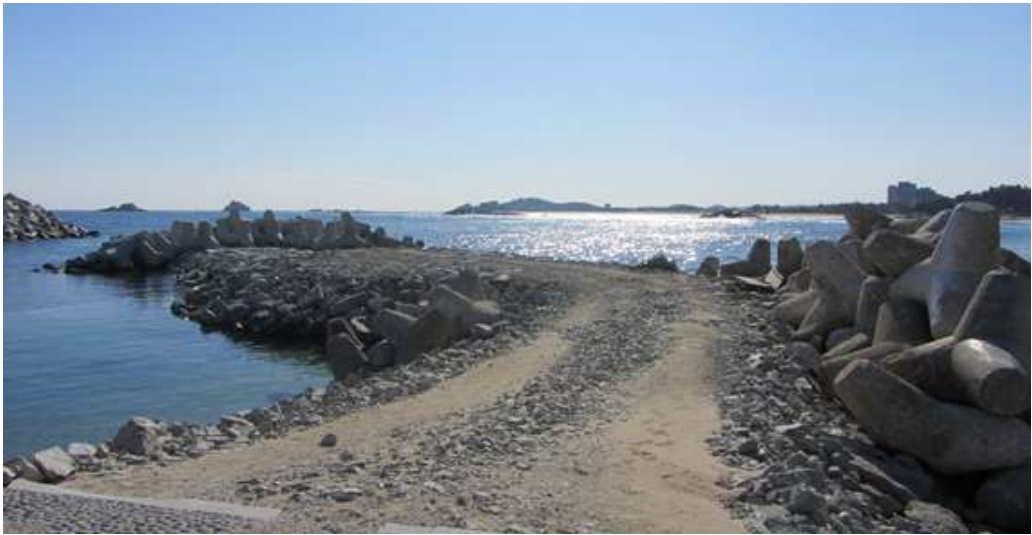
방파제 시공 전
