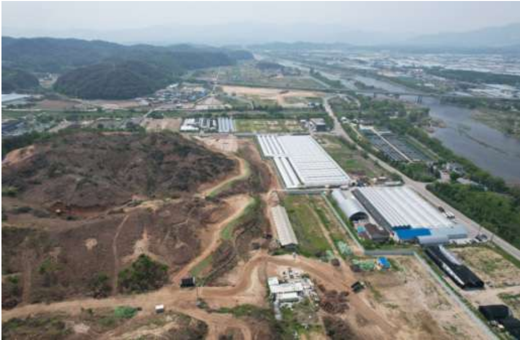
기반조성 공사 추진중
