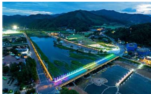
평창 달빛흐뭇 낭만 ROAD 준공 사진
