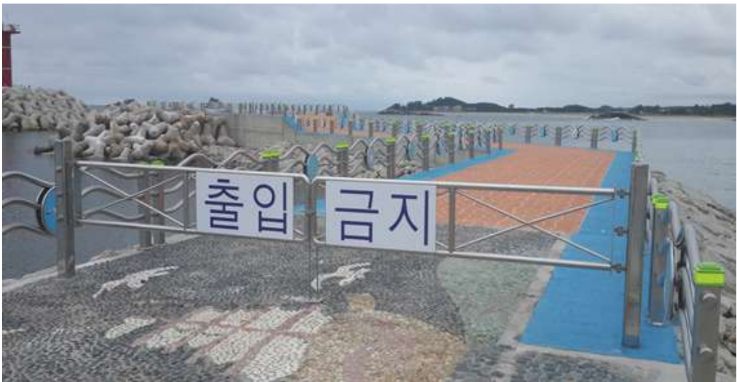
방파제 시공 후
