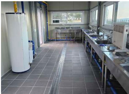
(안전·위생시설 개보수) 개수대 개보수
