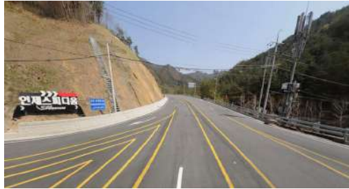
(인제) 모험레포츠체험시설 접속로 개량사업
